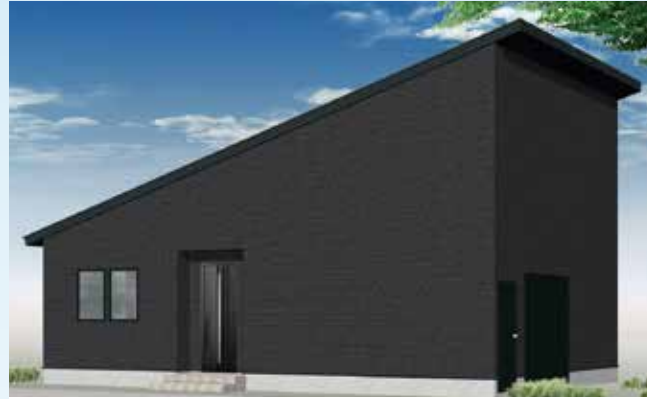
外断熱工法 平家・ガレージのある家
